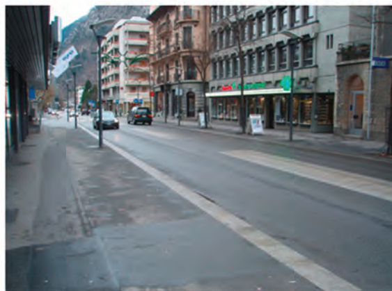
Viège (VS), route cantonale principale en traversée de localité avec charges de trafic similaires Contexte historique et espace public valorisé malgré les charges de trafic importantes
