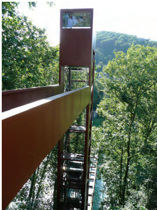
Figure 31 : Exemple d'un franchissement de barrière : ascenseur urbain à Baden en prolongation d'une passerelle sur la Limmat
